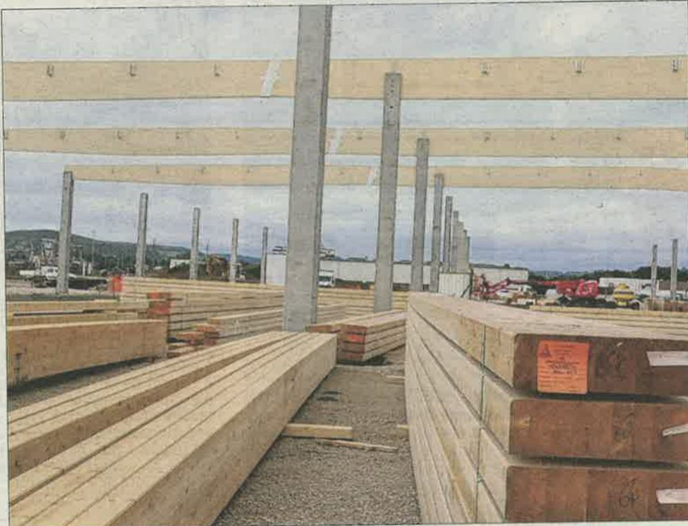
La nouvelle usine est en train d'être construite sur la dernière parcelle communale de la zone industrielle de Venarey-Les Laumes. Photo LBP/É. B.
